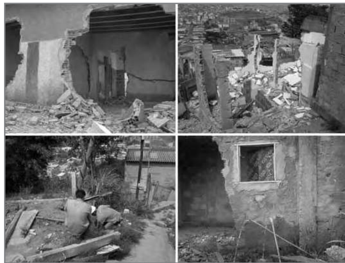
Figuras 11, 12, 13 e 14 • Imagens tomadas na porção superior da bacia do Córrego do Pastinho em novembro de 2008: assim que as famílias desocupam suas moradias, é promovida a demolição parcial: o suficiente para que o imóvel não seja reocupado – e o desligamento do abastecimento de água; a grande quantidade de entulho concentrada nas encostas, além de produzir um cenário de devastação e descuido.
