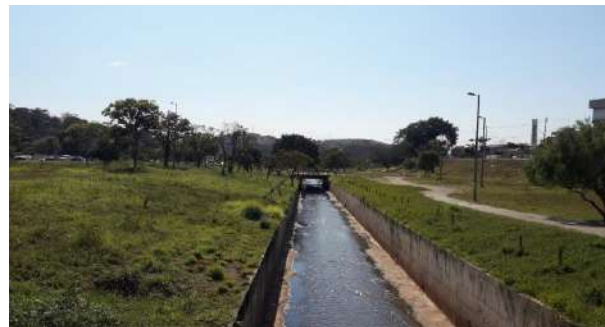
2 – Córrego Sarandi, canalizado em seção aberta ao longo do parque linear
