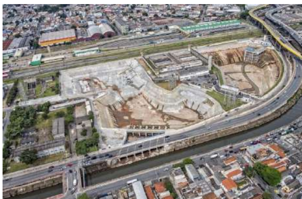
1 - Reservatório Guaramiranga, bacia de detenção seca, sem uso social, no rio Tamanduateí, São Paulo.
