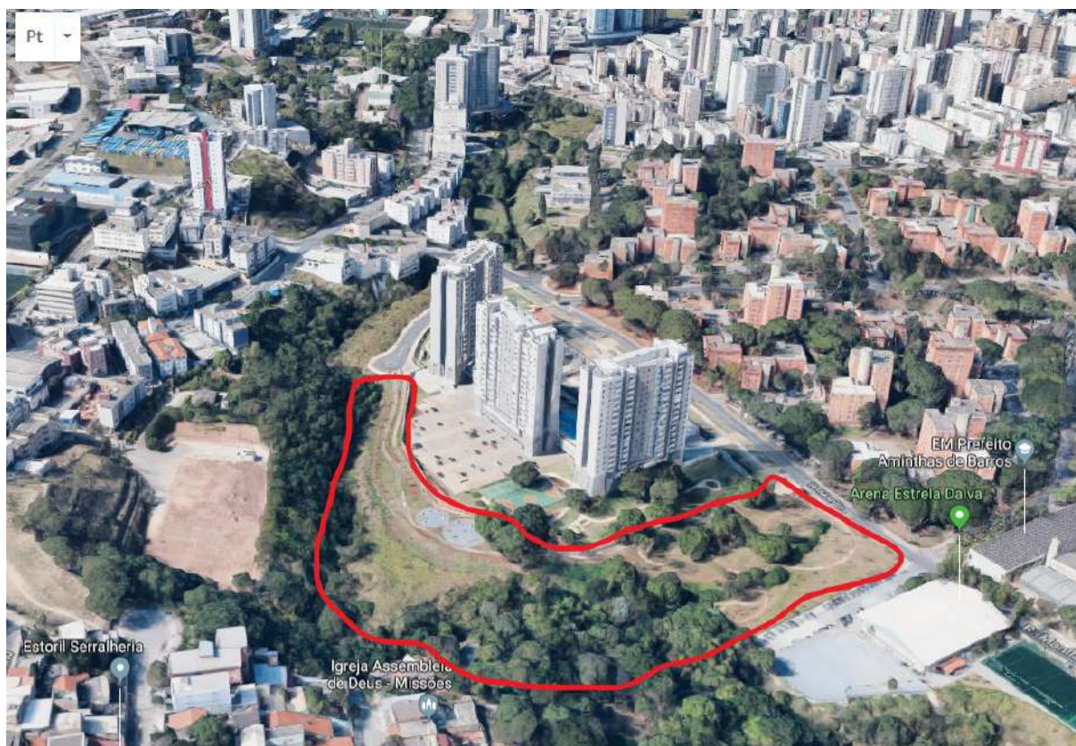
Figura 73: Vista aérea do Parque Estrelinha – destacado em vermelho - implantado em trecho do córrego Cercadinho como medida compensatória pelo empreendimento residencial contíguo
