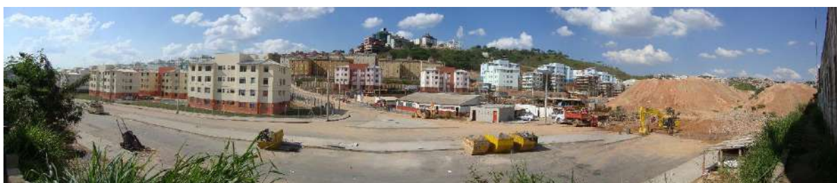
Figura 43: Obras de canalização do córrego São José (afluente do córrego da Ressaca), abertura de sistema viário (avenidas João XXIII, Pedro II e Pres. Tancredo Neves) e reassentamento de famílias no âmbito do PAC / Vila Viva São José
