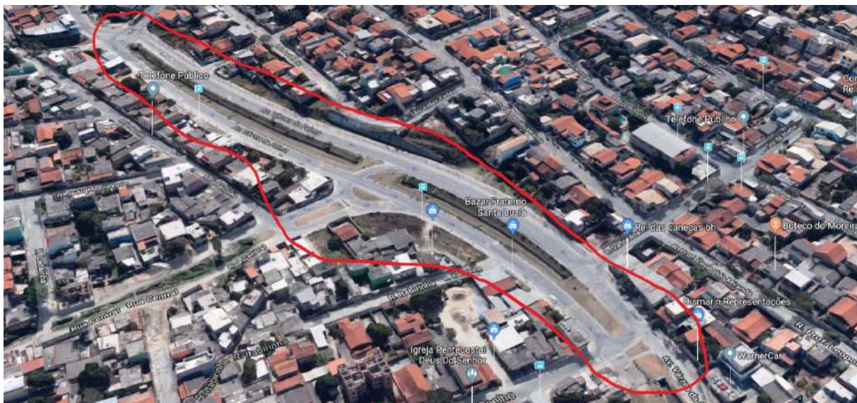
3 - Avenida Várzea da Palma, concluída em 2013 pelo PAC: tradicional solução da avenida sanitária com canalização do córrego homônimo em seção aberta.
