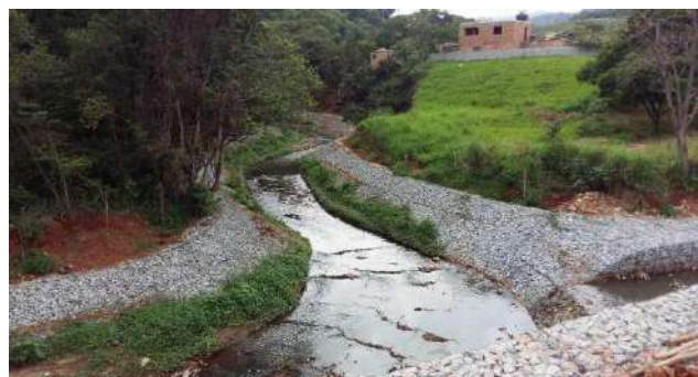
2 – Tratamento de trecho do córrego Bonsucesso na confluência com o córrego da Rua Marselhesa: revestimento da calha menor com Colchão Reno, para proteção contra erosões e revegetação das margens.
