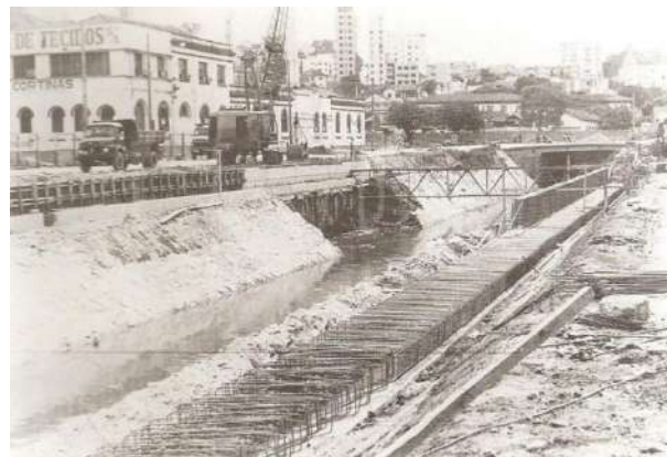
2 - Aspectos das obras de alargamento do canal do Arrudas na Praça da Estação (1984)
