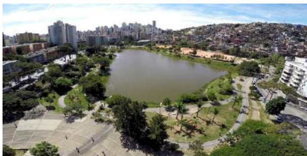
1 - Barragem Santa Lúcia, bacia de retenção em Belo Horizonte, inserida no Parque Municipal Jornalista Eduardo Couri.
