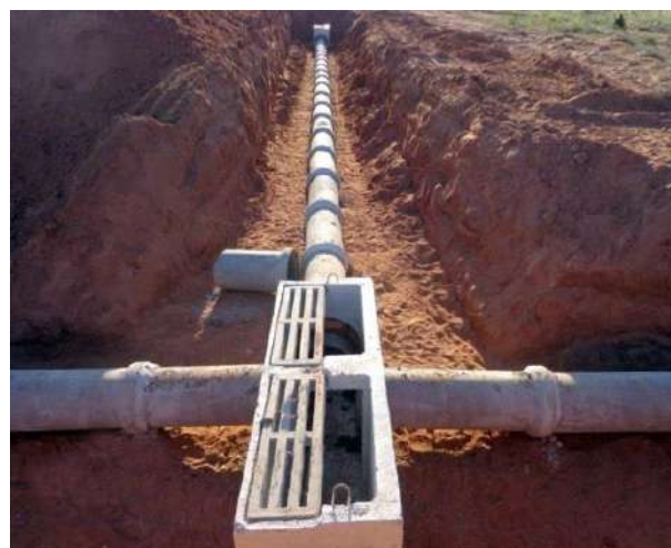
2 – Implantação de rede de microdrenagem.
