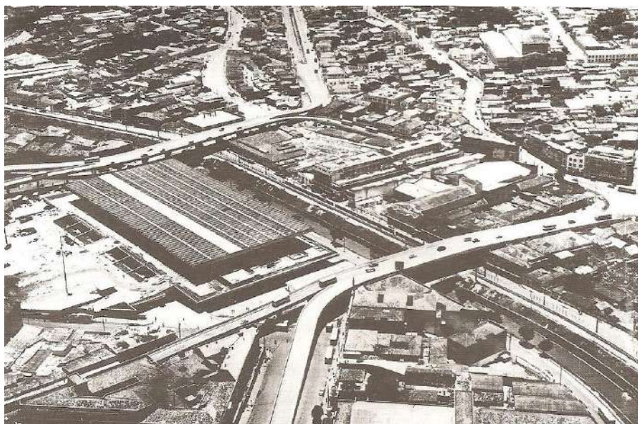
Figura 13: Vale do ribeirão Arrudas, canalizado em seção aberta, à época da construção do Terminal Rodoviário Governador Israel Pinheiro e dos novos viadutos (1970): ao norte do ribeirão Arrudas o bairro Lagoinha e, ao sul, a Área Central de Belo Horizonte, delimitada pela Avenida do Contorno
