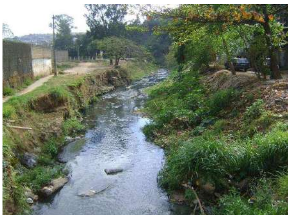
1 – Trecho do córrego Bonsucesso antes das intervenções: degradação morfológica do leito fluvial em relação a sua condição original, devido à urbanização da área de contribuição.
