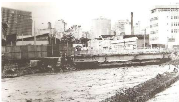
1 - Enchente do ribeirão Arrudas, na altura do cruzamento com a Av. Francisco Sales (data inferida - 1983)
