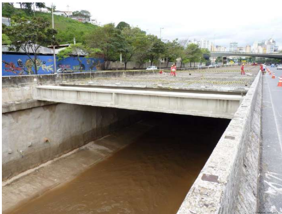
Figura 48: Obras do tamponamento do ribeirão Arrudas em trecho da Av. do Contorno, próximo à Rua Paracatu, em 2010
