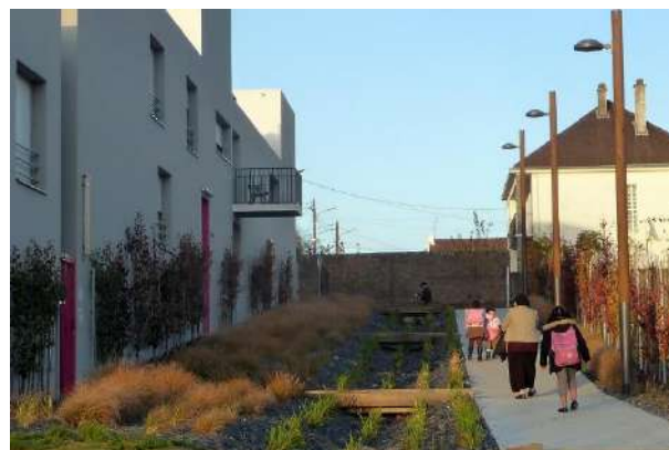
2 - Vala de infiltração no Bottière-Chênaie Ecodistrict, em Nantes, França.
