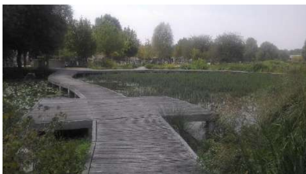
1 - Wetland construído para tratamento das águas do rio Sena, integrando parque público (Parc du Chemin d'Île) em Nanterre, França
