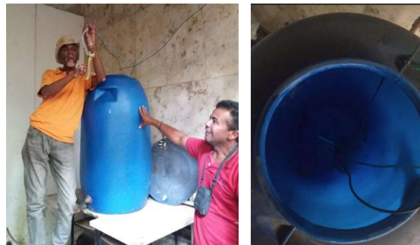
Figura 22: Sistema de aquecimento de água desenvolvido por um morador.
