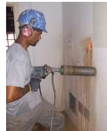
Figura 74: Mutirão: aberturas circulares na fachada
