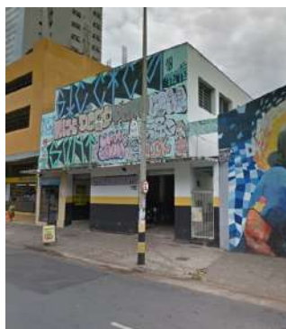
Figura 83: Aspectos do edifício na Rua dos Guaicurus.
