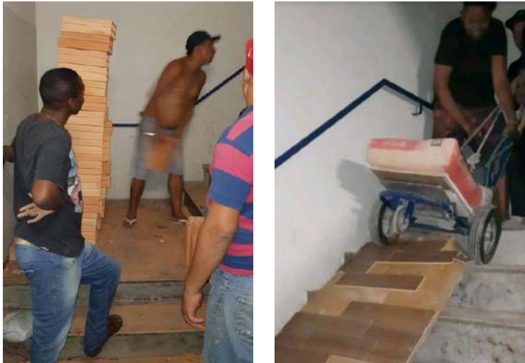
Figura 72: Moradores conduzindo os materiais até os andares.
