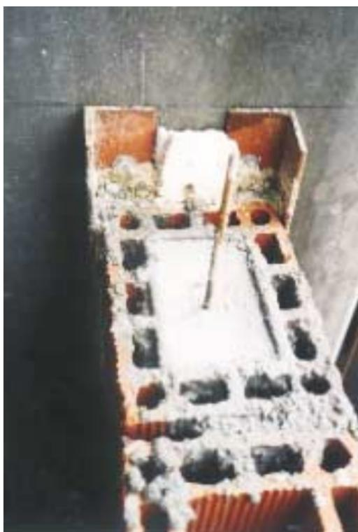
**FIG 4.43a e 4.43b** Aplicação experimental de cantoneiras de aço na interface pilar/alvenaria em projeto de pesquisa desenvolvidos por Medeiros e Franco (1999).
