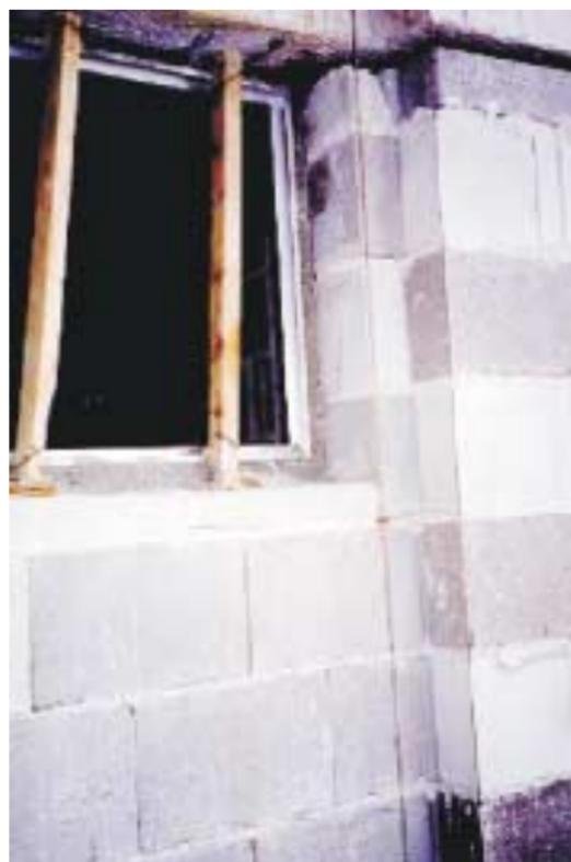
**FIG. 4.31a e 4.31b** Compatibilização da espessura da parede de alvenaria com as dimensões dos pilares e vigas na interface entre os subsistemas estrutura e vedações verticais. Observar a presença da tela metálica, na foto à esquerda, promovendo a ligação do pano de alvenaria com o pilar e que também promoverá a ligação entre os planos paralelos de parede, como ilustra a foto à direita.
