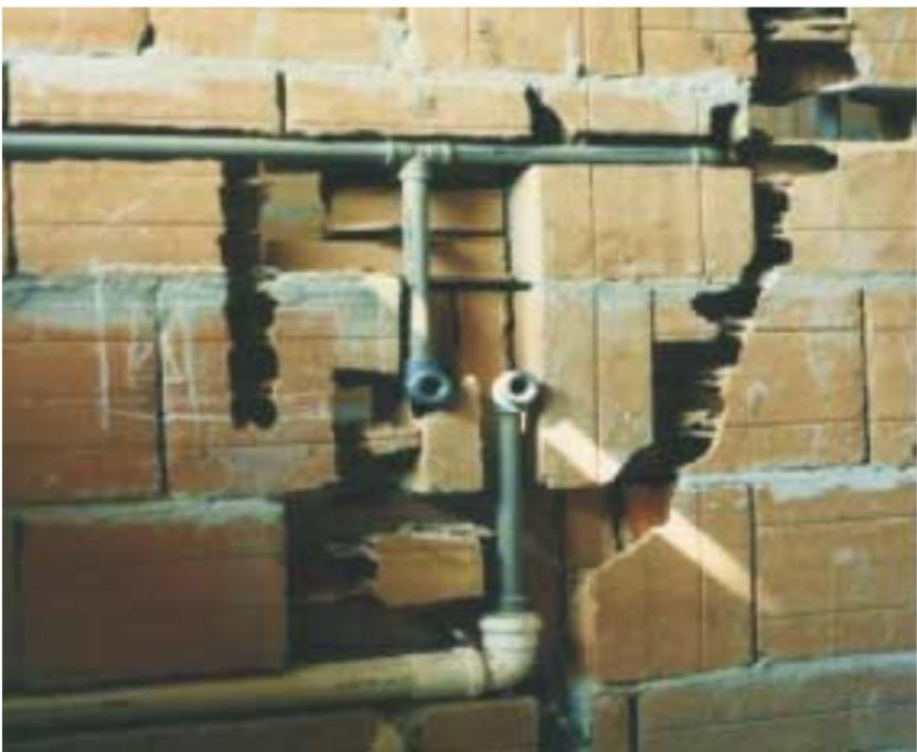
**FIG. 4.2** *Registro em obra: quebra de componentes; geração de entulho e consumo de mão-de-obra para sua retirada; retrabalho na reconstituição dos rasgos e consumo extra de argamassa; comprometimento da produtividade; probabilidade de aparecimento de fissuras na interface dos componentes cerâmicos com a argamassa de assentamento que, em geral, transferem-se para a camada de revestimento, especialmente se forem utilizadas argamassas rígidas para a reconstituição dos rasgos.*
