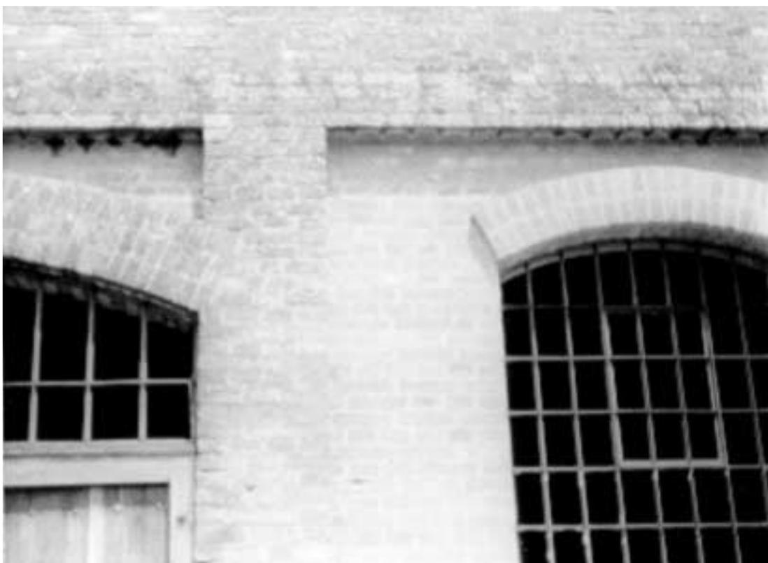
**FIG. 2.18b** *Idem anterior. Detalhe da articulação entre pilar, viga, parede de vedação e vergas e vãos de esquadrias.*
