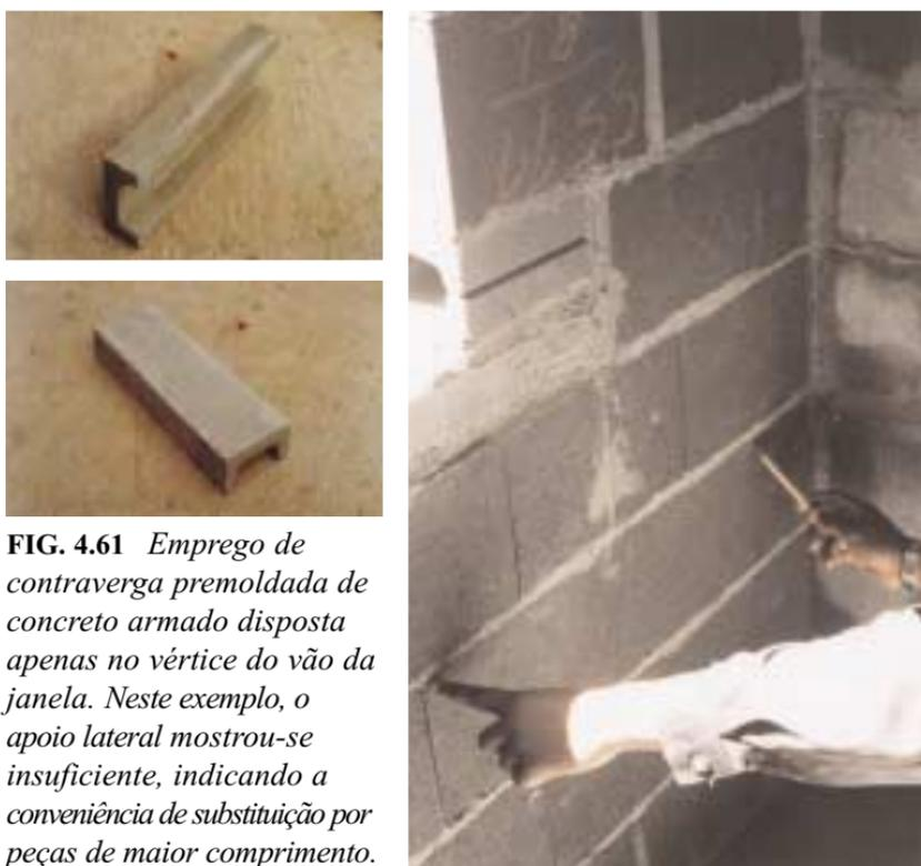
**FIG. 4.61** Emprego de contraverga premoldada de concreto armado disposta apenas no vértice do vão da janela. Neste exemplo, o apoio lateral mostrou-se insuficiente, indicando a conveniência de substituição por peças de maior comprimento.
