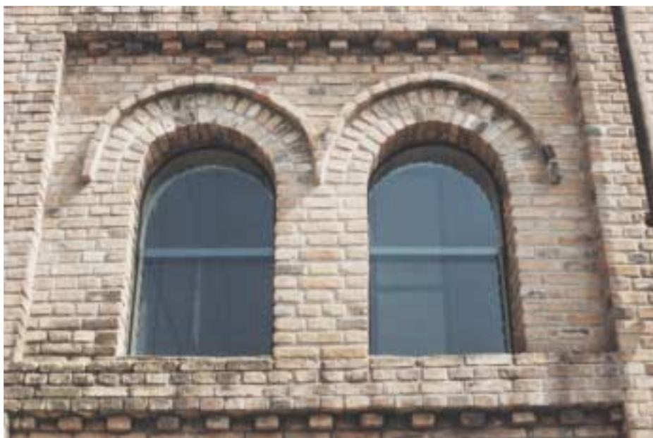
**FIG. 2.14b** Vão modular que compõe a fachada do edifício. A solução evidencia a composição estrutural de cada módulo que se propaga horizontal e verticalmente. Observa-se, também, que os recuos nos planos da fachada, associados a componentes ressaltados conferem proteção ao plano das esquadrias.
