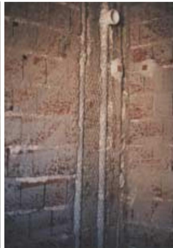
também comumente empregada na tentativa de proteger as tubulações incorporadas às paredes externas, dado à maior suscetibilidade destas áreas às variações de temperatura e umidade (Fig. 4.75). No entanto, quando se trata de tubulações que conduzam líquidos ou gases, deve-se evitar seu confinamento em paredes ou elementos estruturais, sendo recomendável soluções que assegurem a independência dos subsistemas e facilitem as operações de vistoria e manutenção.
