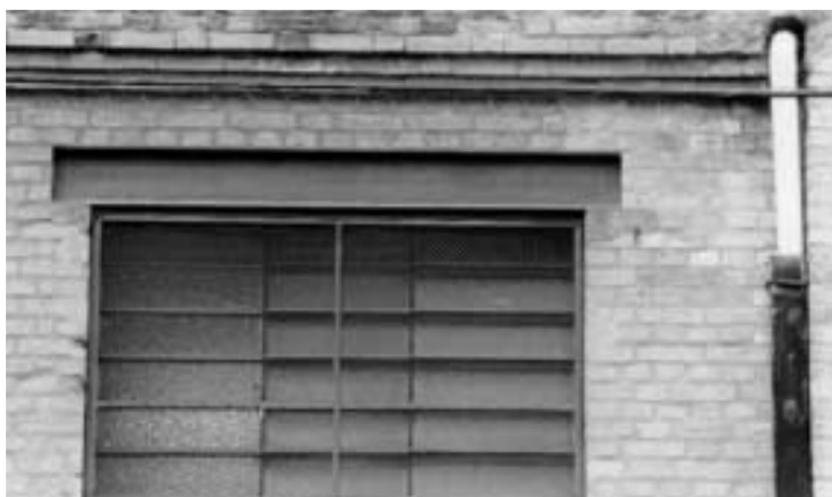
**FIG. 4.59** *Alvenarias resistentes tradicionais - uso de vergas metálicas. (Edifício Industrial - Mooca - SP)*
