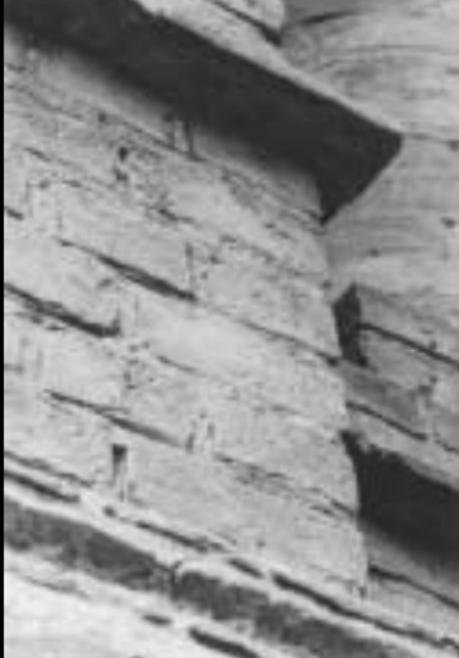
*FIG. 3.9a e 3.9b Detalhe de pilar na Pinacoteca do Estado de SP, também dotado de ressaltos para descolamento e expulsão da película d'água.*
