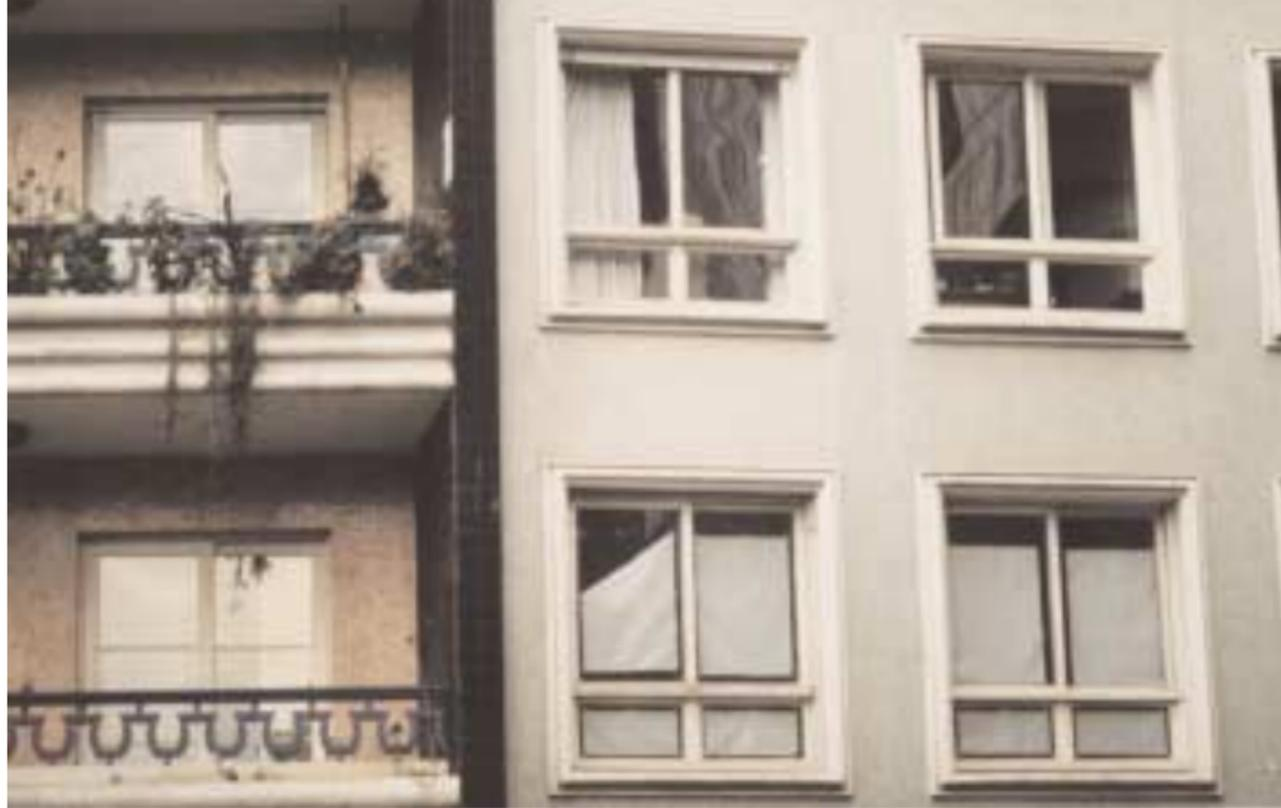
**FIG. 3.16** *Edifício construído por Artaxo Jurado, na década de 50, em São Paulo: na composição das fachadas estão presentes importantes elementos de proteção e minimização do grau de exposição de seus componentes às intempéries.*
