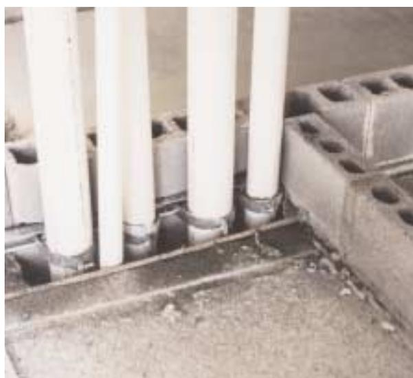
**FIG 4.49** *A canaleta metálica é fixada à estrutura e, com auxílio de abraçadeiras metálicas, são presas as prumadas verticais de maior diâmetro. Observar a proteção do tubo na região onde é "abraçado", evitando-se sua danificação ao ser apertada a braçadeira.*
