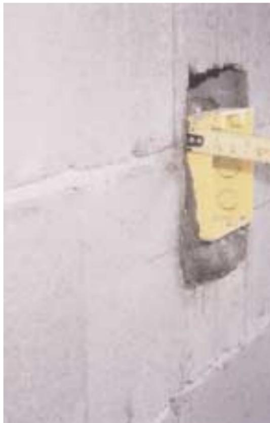
**FIG. 4.82** *O projeto de alvenaria deverá considerar o tipo e espessura das camadas de revestimento e acabamento a serem aplicadas sobre a parede 'em osso', para que os componentes a ela incorporados estejam na posição especificada para a parede 'acabada'.*
