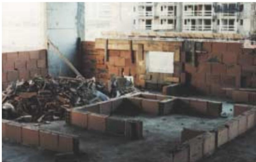
**FIG. 4.57** *Moldagem in loco de contraverga, alternativa que impõe a interrupção da elevação da parede para a montagem e travamento das formas, colocação das armaduras, concretagem e cura do concreto e desforma.*
