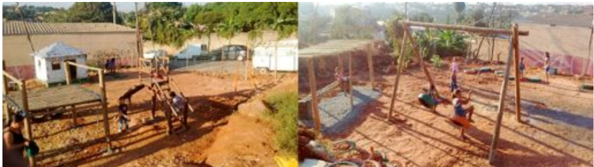
Figura 8 – Parquinho da Dandara antes do vandalismo. Fonte: Helena Lana, 2016.
