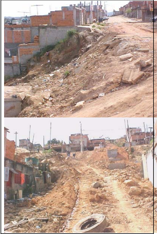
Fotos: acervo da Secretaria de Obras da Prefeitura de Jandira. Rua Maria Joana Leopoldina (antiga Rua Um) antes da construção do Muro de Arrimo
