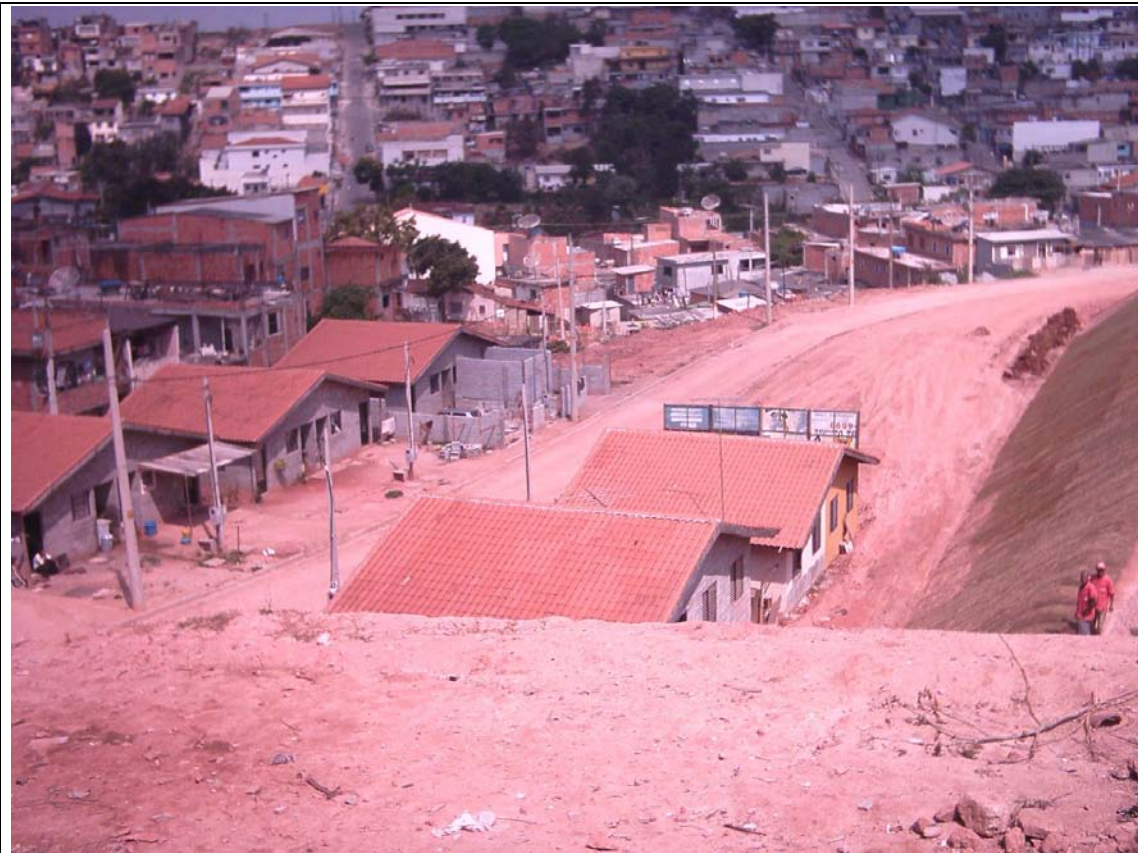
Foto acervo da Secretaria de Habitação, Desenvolvimento Urbano e Ambiental. Construção das casas do Figueirão
