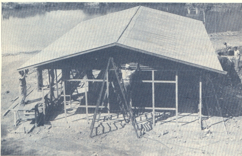
Concluída a estrutura é colocada a cobertura e feito o acabamento do fôrro
