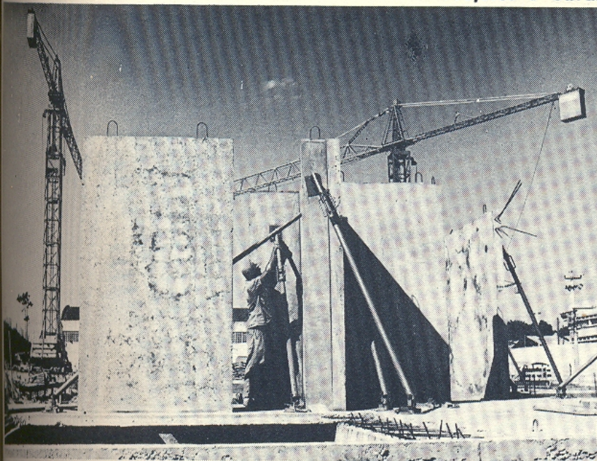
"Estais" telescópicos ajudam na colocação das peças em posição vertical
