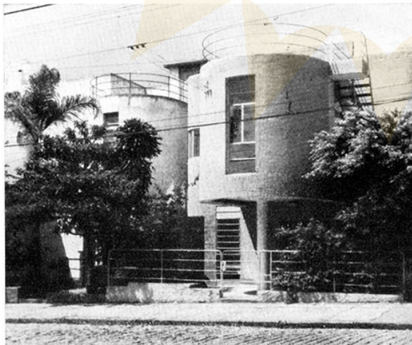
Casas construídas por Flávio de Carvalho, na rua Oscar Freire, em São Paulo. Por suas características plásticas e construtivas e por sua organização externa, essas residências fugiram aos padrões correntes em sua época
