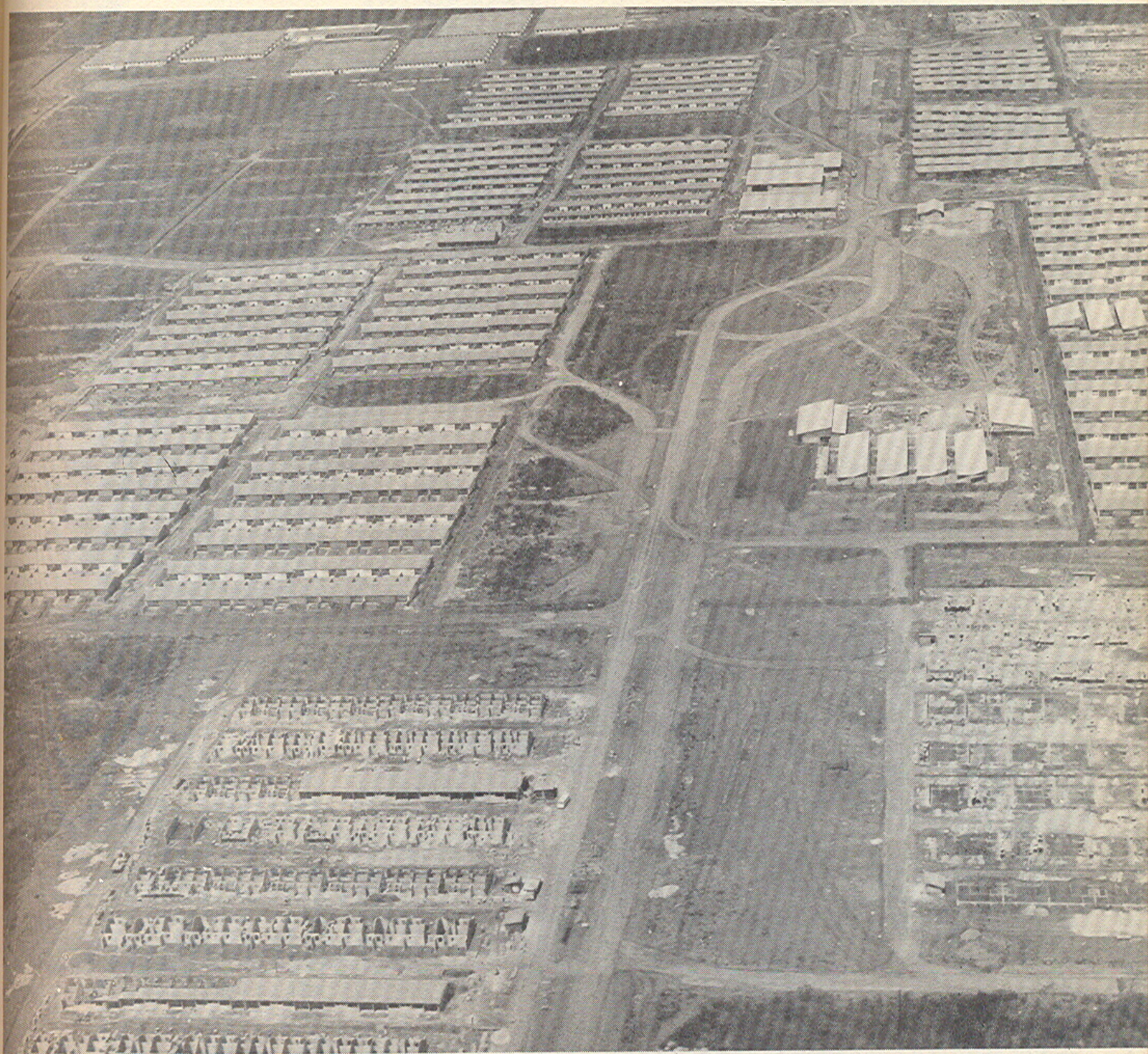
Vista geral da parte já construída da zona habitacional, notando-se bem as vias de circulação que foram abertas até agora
