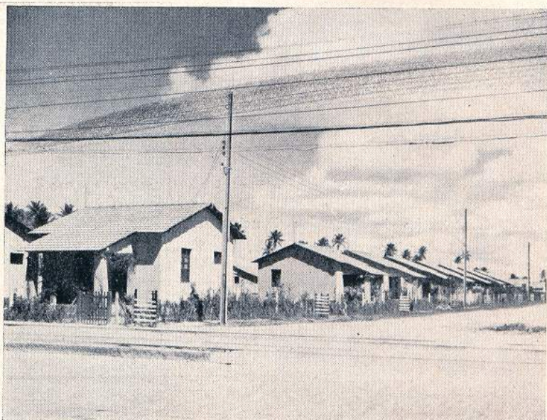
Aspécto parcial da Vila dos Trabalhadores em Transportes e Cargas. Bongí.
