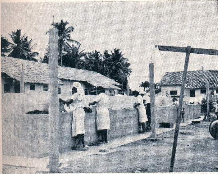
Aspécto do "lavadouro" da Vila das Lavadeiras em Areias. Recife.
