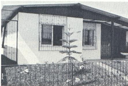
**Painéis estruturados em concreto armado para grandes conjuntos habitacionais, utilizados na construção de 4 mil casas na Grande Porto Alegre.**
