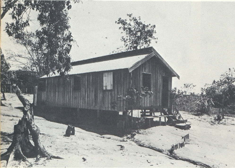
Residência rural: Construção de madeira e cobertura de alumínio
