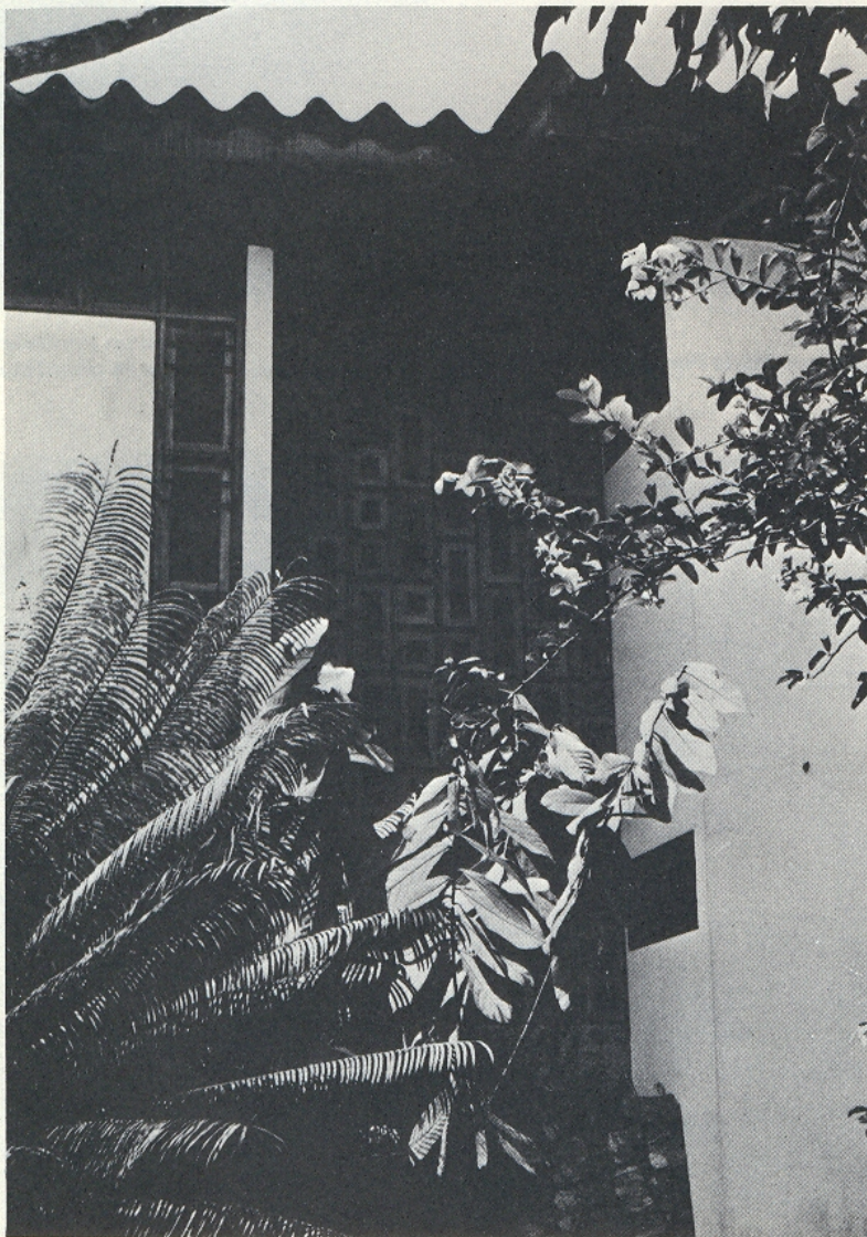
Detalhes de elementos vazados que proporcionam ventilação permanente
