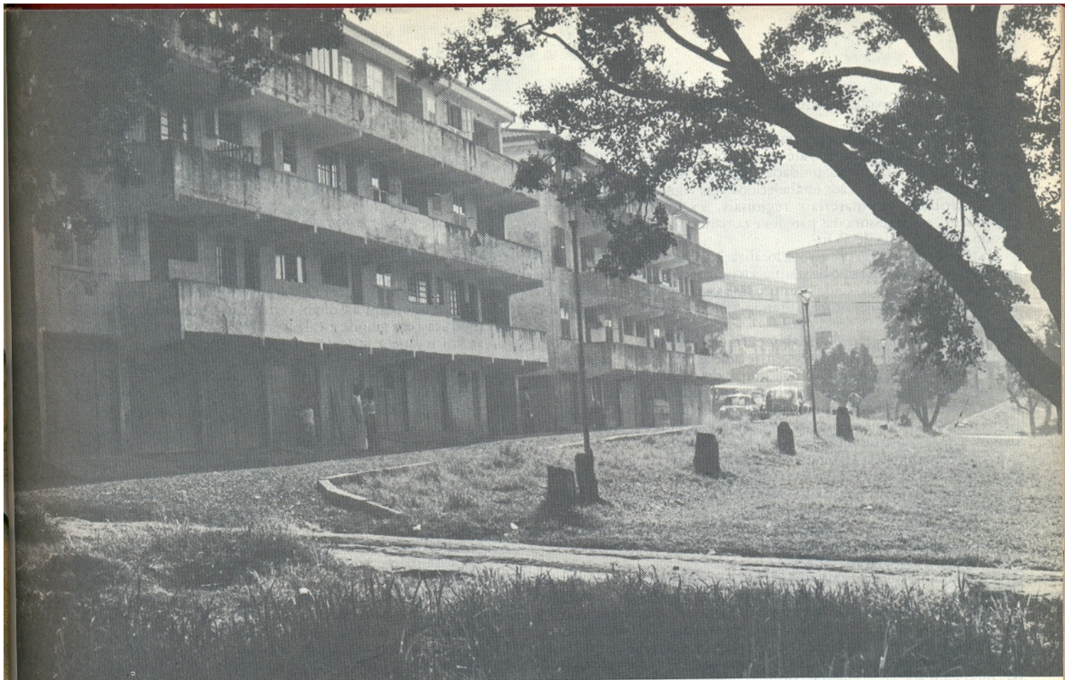
Conjunto do IAPI, construído entre 37 e 45 em Santo André, SP (Foto de arquivo)
