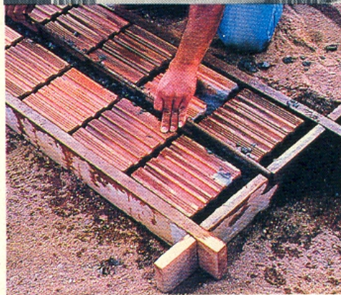
Com as mesmas fôrmas e gabaritos simples, elaboração de painéis de laje, parede, cobertura e escada. A cerâmica (tijolos ou telhas) é solidarizada com nervuras de concreto
