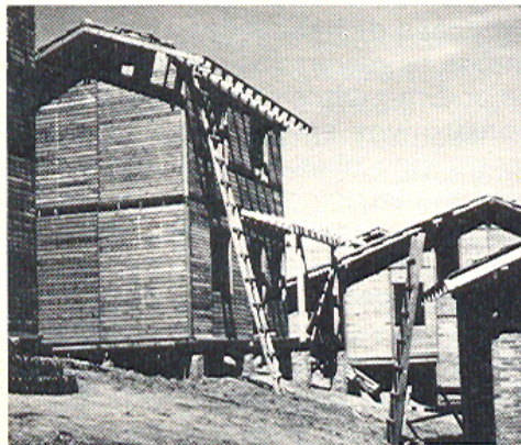
Alternativa tecnológica regional: pré-fabricadas em madeira de reflorestamento pinus spp
