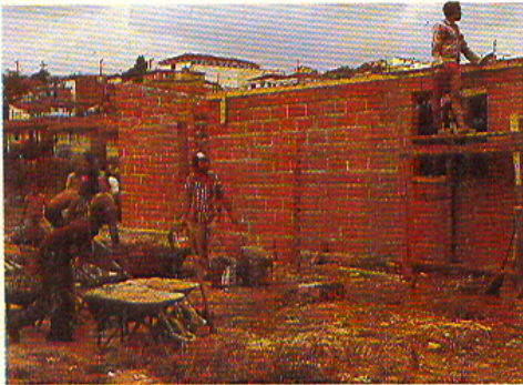
Construção por ajuda mútua empregando blocos cerâmicos estruturais
