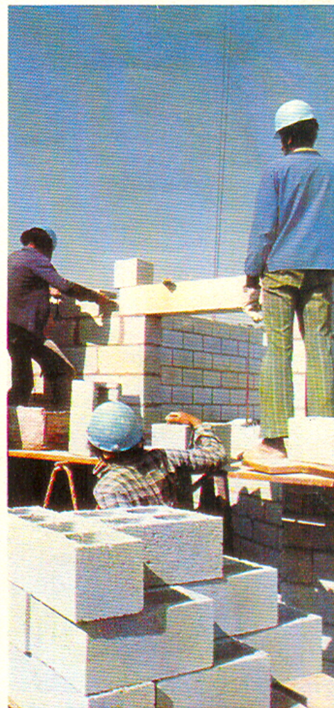
Racionalização de processo convencional: alvenaria estrutural de blocos de concreto
