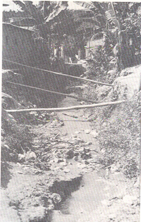
Obras de canalização de córrego na Vila Biquinhas
