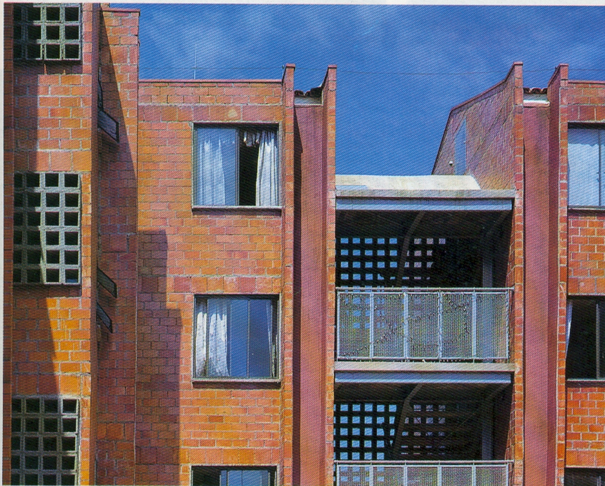
Tipologia B: detalhe de fachada, com destaque para as canaletas de águas pluviais
