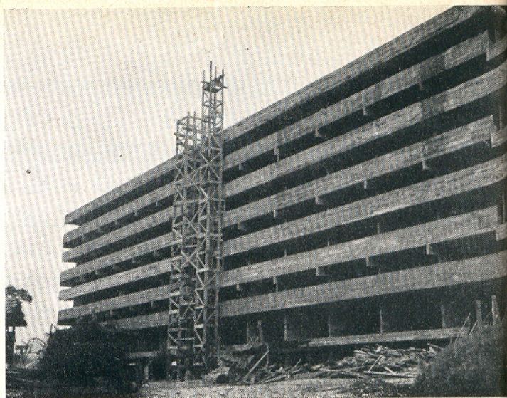
vista da estrutura do bloco A1 e A2
