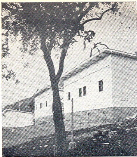
Casas pré-fabricadas, realizadas na Itália por meio do sistema pré-fabricado Arbor.
