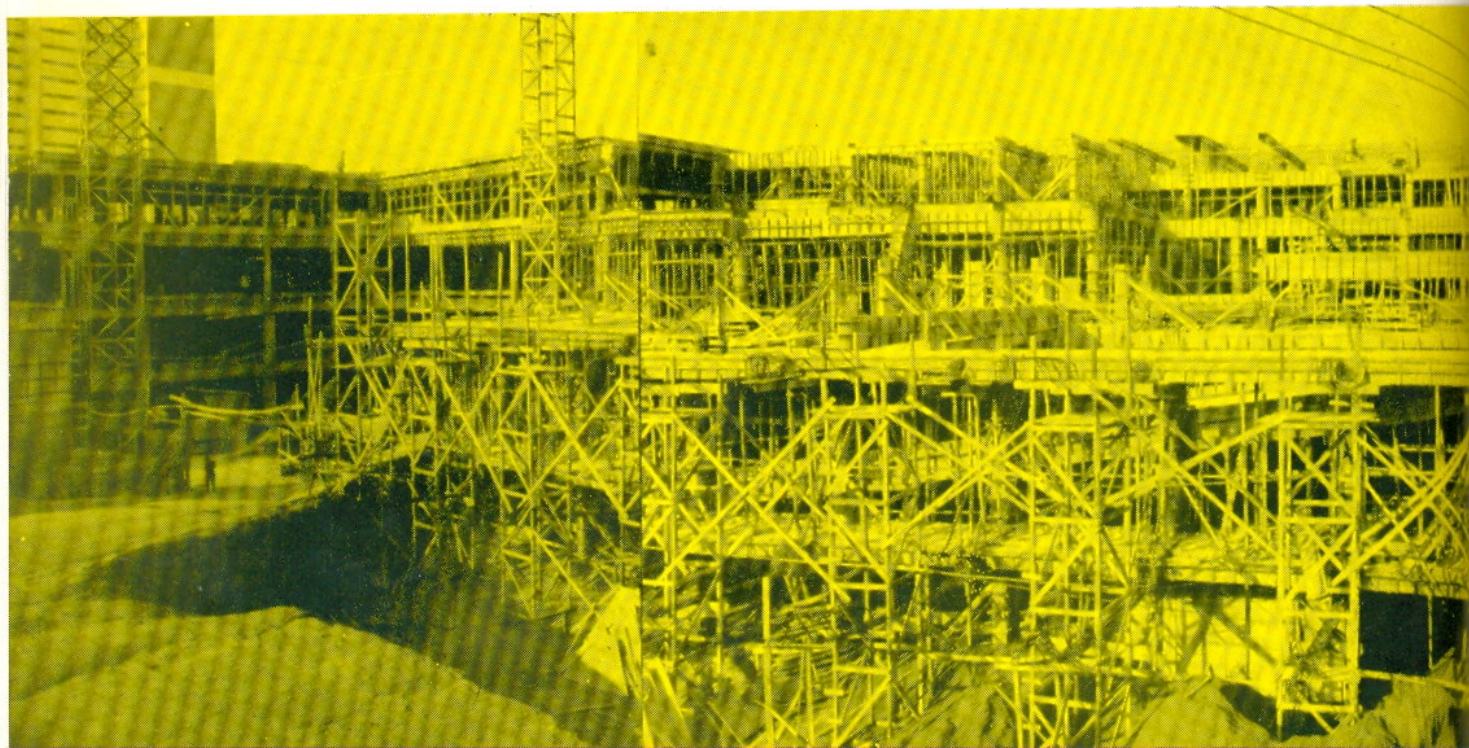
Aspecto interno da construção do conjunto
