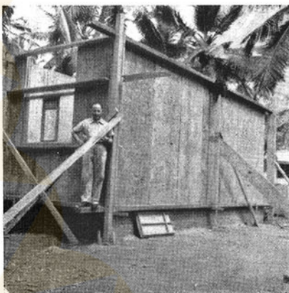
Vista das paredes durante a construção
