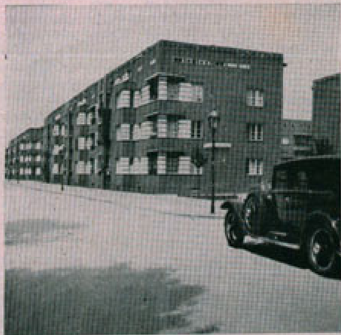
Fig. 16 — Mostra uma parte dos prédios feitos de 1924 a 1925, pela "Berliner Spar-und Bauverein" nas imediações do parque SCHILLER. Fachadas de tijolos aparentes de Rathenow, faixas rebocadas e caiadas de branco e balcões com pilares de concreto-armado sem revestimento.
