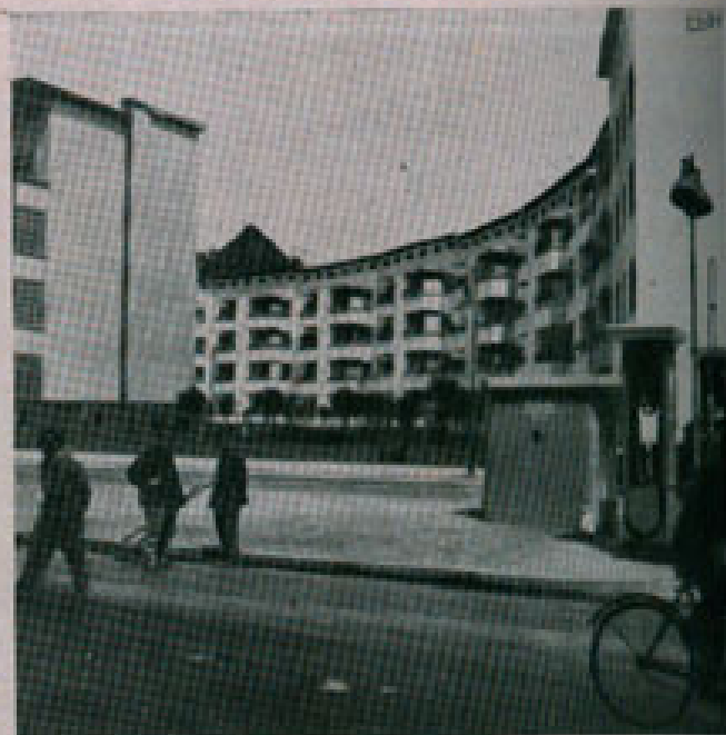
Fig. 19 — Detalhes do grupo construído na GRELISTRASSE pela "GEHAG" em 1927, com balcões genéricos que dão grande movimento às fachadas.
