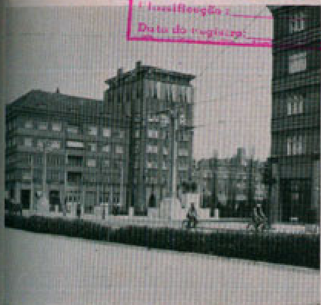
Fig. 21 — Prédios de moradias que a empresa dos bondes elétricos fez construir pelo arquiteto J. CRAMER, na MUELLESSTRASSE, envolvendo os grandes galpões de depósito dos carros. A parte aberta, com as linhas férreas, tem um aspecto monumental devido aos torreões simétricos.
