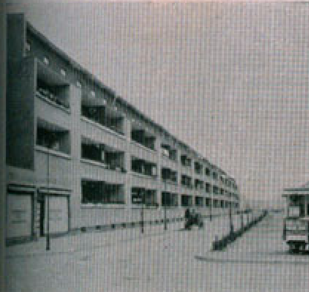
Fig. 20 — Grandes blocos na BUSCHALLEE do mesmo bairro, feitos como os anteriores pela "GEHAG". Grandes "loggie" e profundas.
