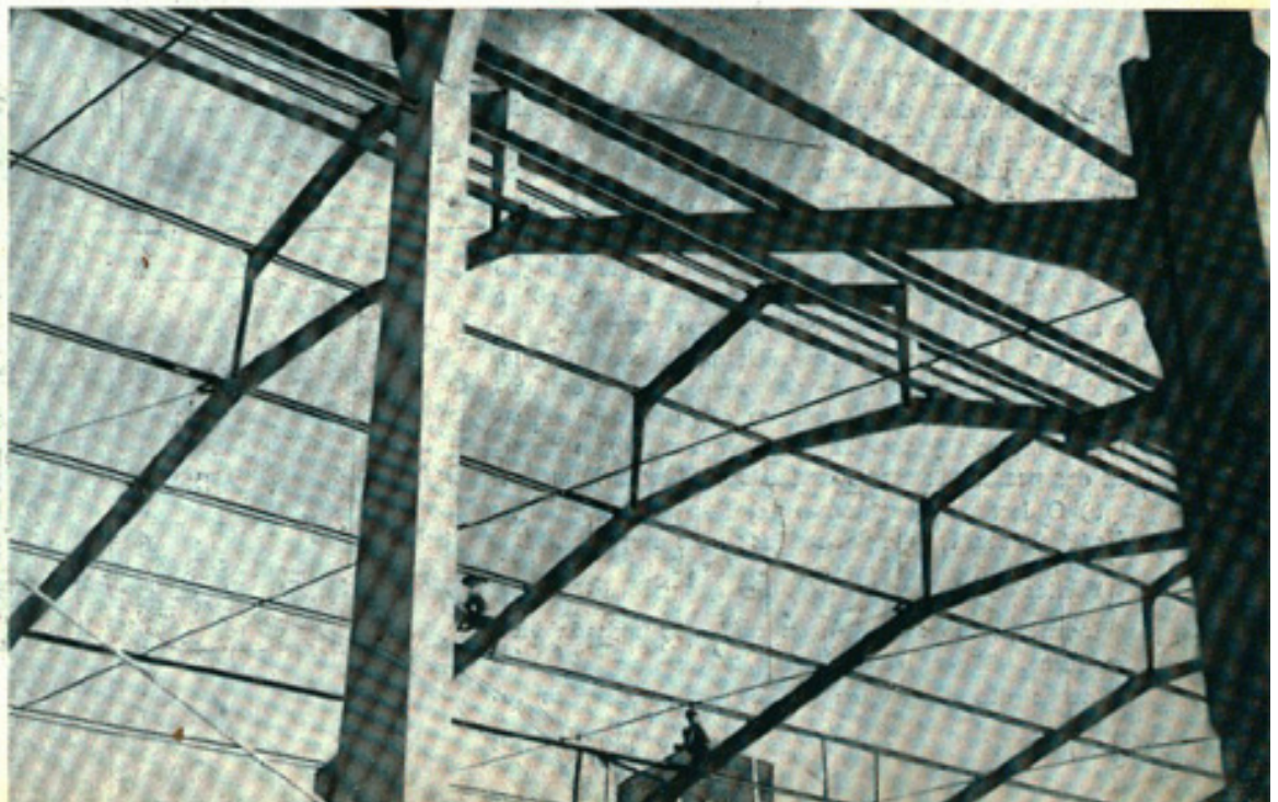
As estruturas "Toschi" durante a primeira fase de montagem.
