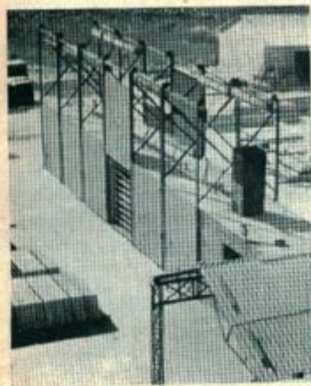
Itália: Usina de peças pré-fabricadas de concreto armado. Vista dos estufos para saneamento rápido (de "Prefabbricare")
