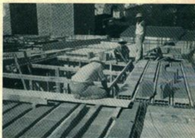
Pré-fabricação no Brasil - Colocação de lajes Volterra
