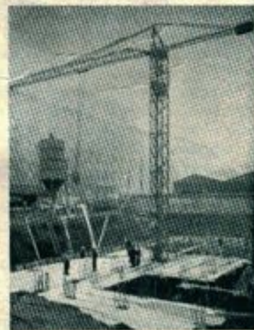
França — Novos equipamentos para canteiros. Guindastes Pingon com torre telescópica e sistema de engastamento na caixa do elevador
