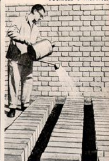
Para a cura adequada os blocos precisam ser regados durante 2 ou 3 dias
