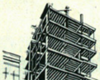
APRESSAM A ENTREGA DAS OBRAS
