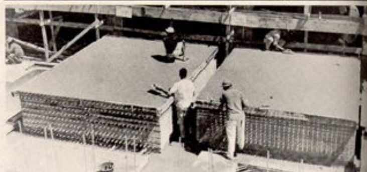
Lajes moldadas pelo sistema de pilhas; a altura costuma chegar a 20 metros
