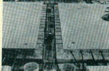
3 Montagem de painéis portantes. Notar os gabaritos de alinhamento, espaçamento e prumo. Neste caso a torre da grua era fixa e desenvolvia-se dentro do poço do elevador, sendo desmontada no fim
