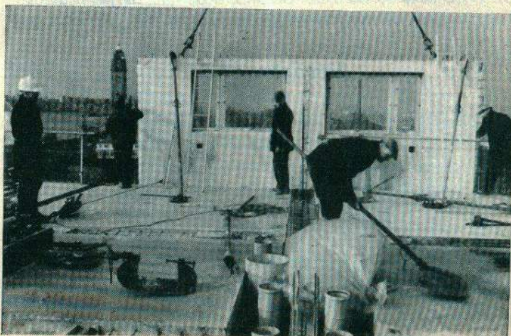
4 Montagem de um painel de fachada. O operário em primeiro plano está recolhendo um gabarito que permitirá manter o painel fixo e aprumado quando a grua for liberada
