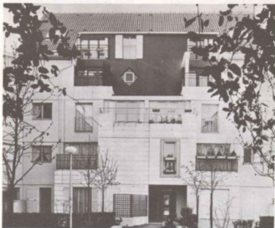
em Marne la Vallée, subúrbio de Paris, detalhe de conjunto residencial construído nos anos 70, de acordo com a política habitacional do governo francês no sentido de incrementar a construção por componentes modulares. Arq.:AREA
