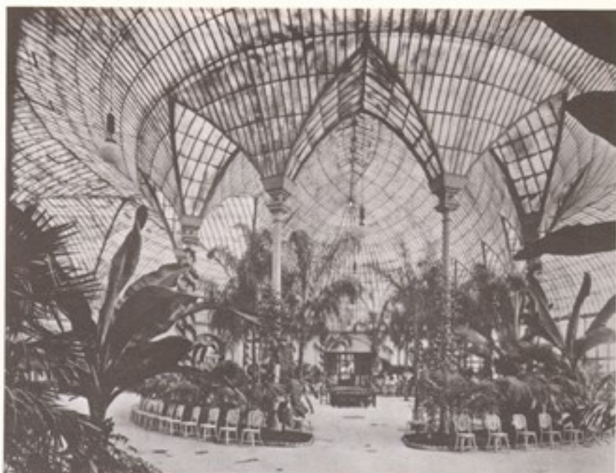
ferro fundido e vidro, no Palmarium do Palácio de Inverno de Pau, no Sul da França
