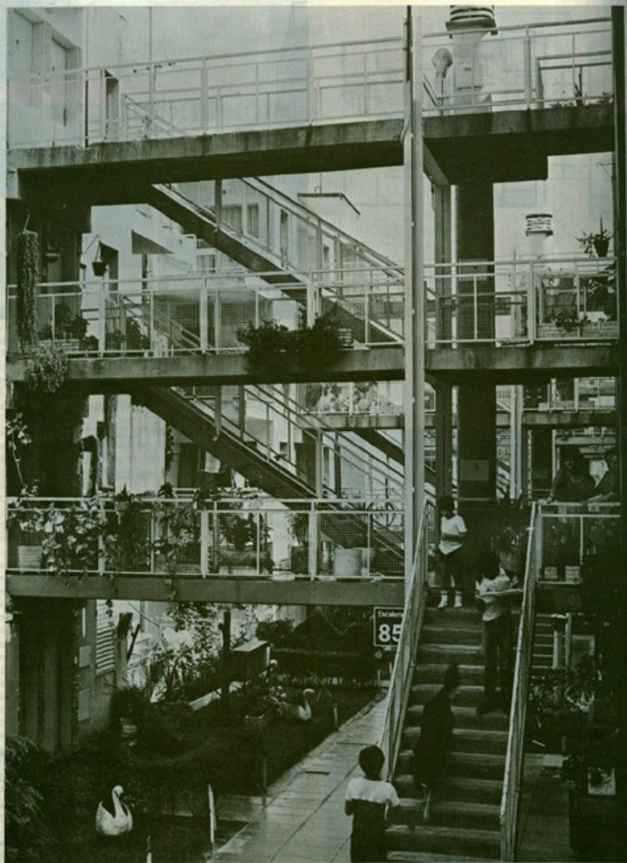
soldati: escadas e passarelas
