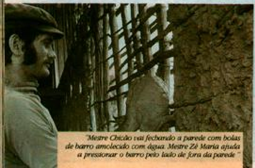
"A primeira etapa na formação das paredes é a colocação dos enchametes — varas grossas fincadas no solo, espaçadas 20 cm umas das outras. Os homens, trabalhando sempre em dupla, um pelo lado de dentro, outro pelo lado de fora, amarram as varas finas, paralelas, presas aos dois lados com barbante de sisal"
