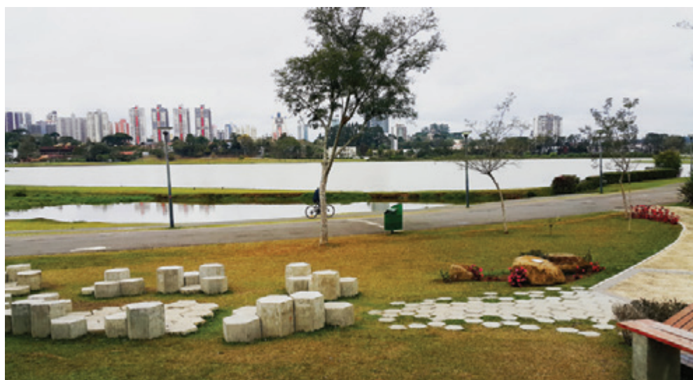
Figura 43. Parque polivalente junto ao rio Barigui com bacia de retenção que impede inundações das zonas urbanizadas.
