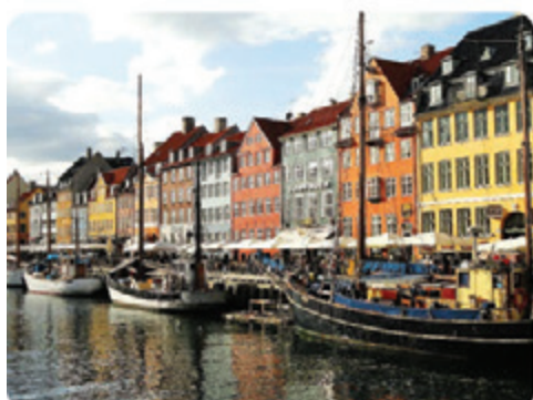
10. SBN para gestão de águas pluviais e redução do risco de inundações (Copenhague, Dinamarca)
