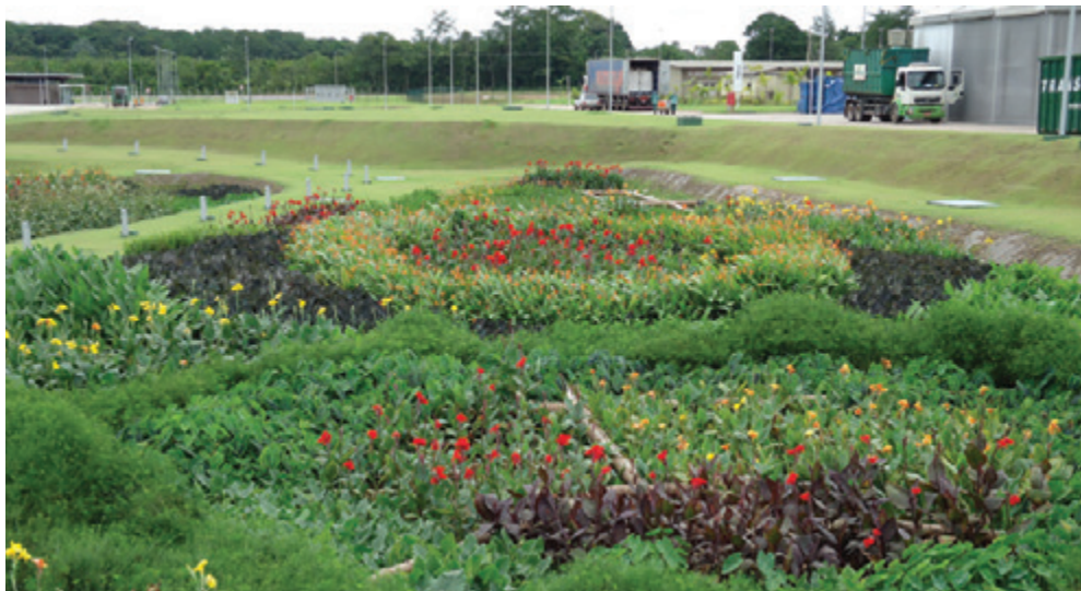
Figura 65. Vista dos jardins filtrantes que tratam as águas residuais da fábrica de cosméticos na região metropolitana de Belém na Amazônia.
