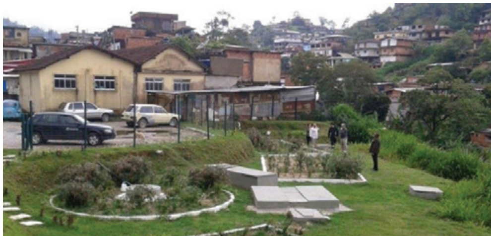
Figura 63. Solução baseada na natureza para tratar águas residuais: biodigestor e várzea construída em Vila Ipanema, Petrópolis.
