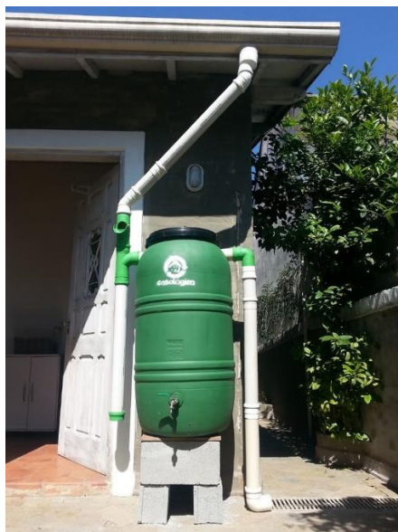
Figura 27: Implantação de reservatório individual
