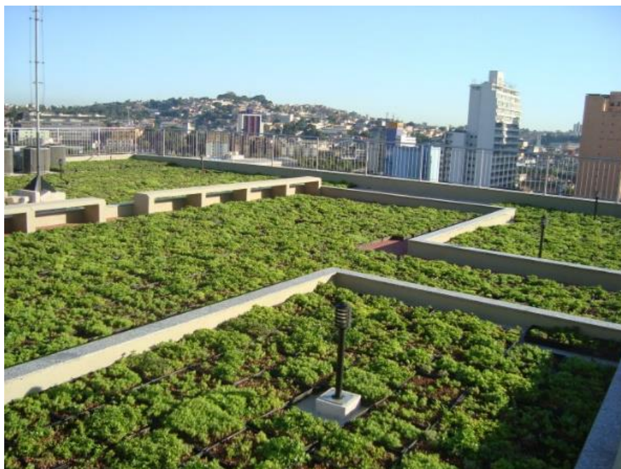
Figura 21: Implantação de telhado verde no Banco do Brasil – Belo Horizonte
