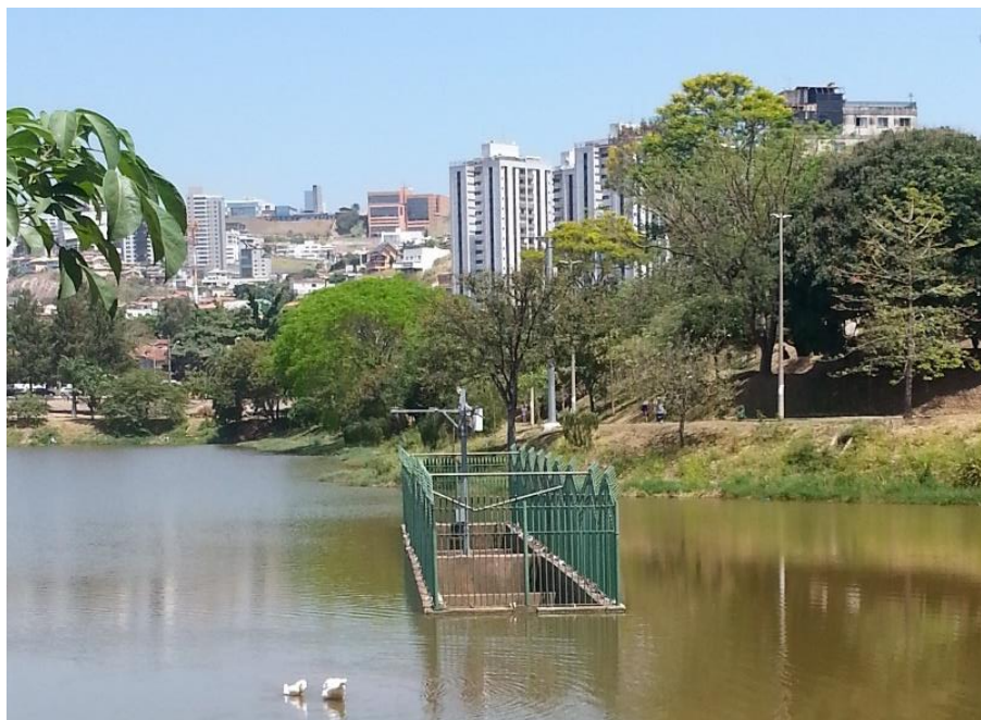
Figura 35: Vertedor do canal subterrâneo no reservatório Santa Lúcia
