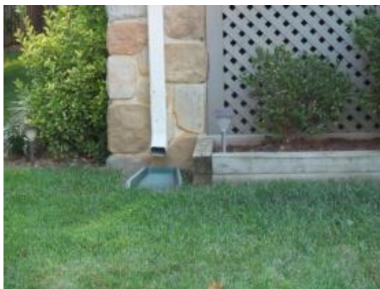
Figura 29: Implantação de desconexão de telhados
