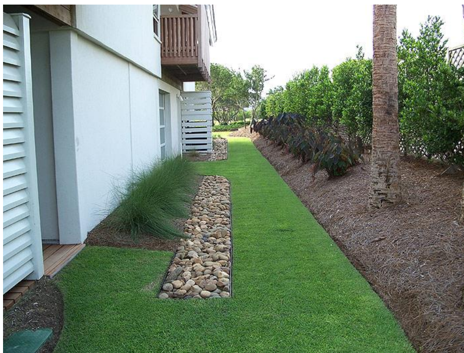
Figura 22: Implantação de trincheira de infiltração
