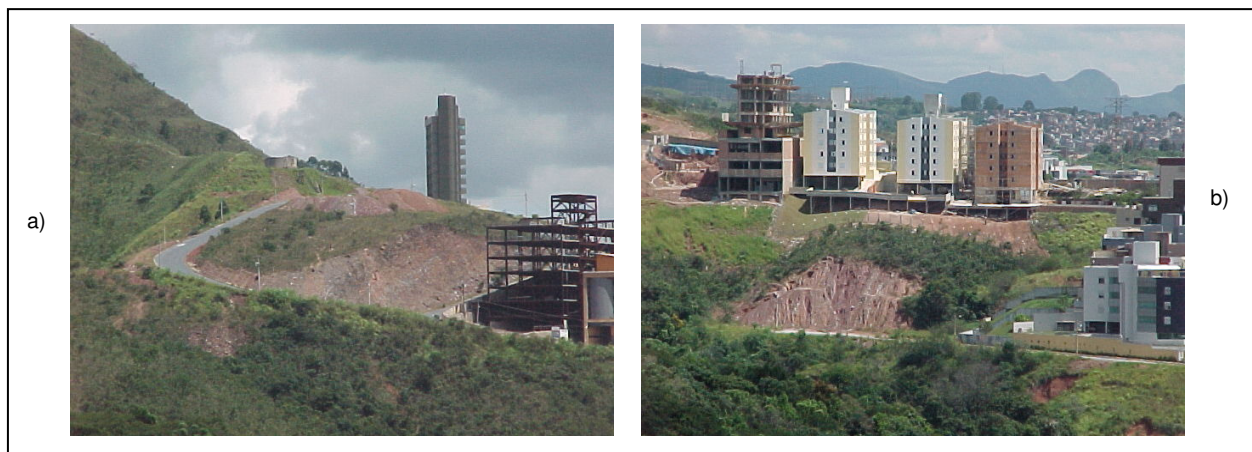
Figura 17: Ocupação das encostas no entorno da EE Cercadinho a) Abertura de novas ruas vertente acima b) Prédios localizado no topo de um talude Fonte: MENDONÇA, Luís; 2003.
