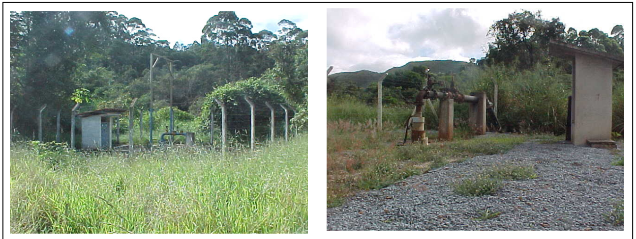
Figura 10: Poços tubulares de captação d'água do interior da EE Cercadinho Fonte: MENDONÇA, Luís; 2003. Acervo próprio.
