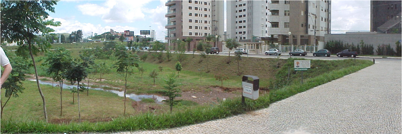
Figura 16: Entorno da depressão formada pela Lagoa Seca impermeabilizada Fonte: MENDONCA, Luís: 2003.
